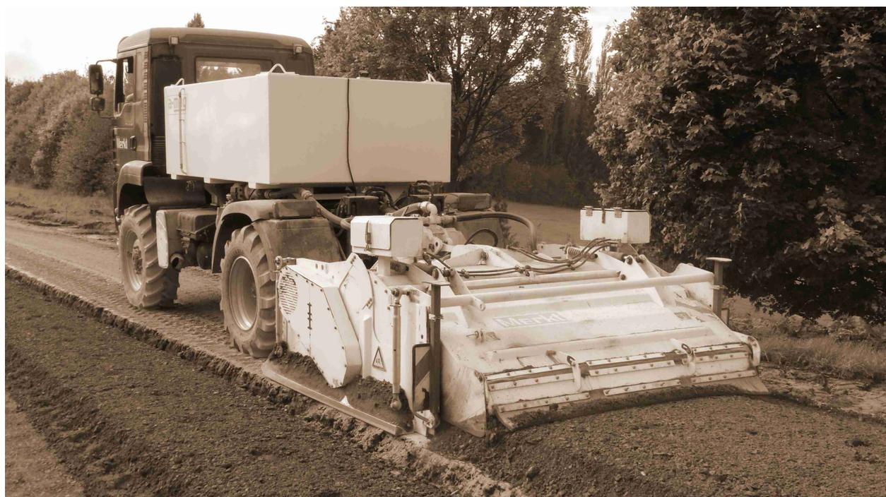
**Einsatz in der Zementverfestigung mit exakter Wassereindüsung im Mischraum.**
